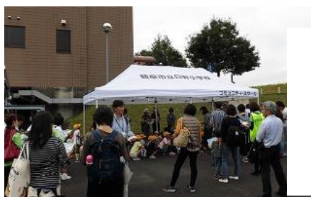
日野揚排水機場
